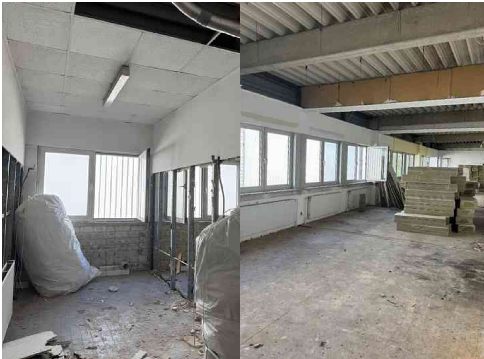
Abriss der alten Wände im Büroschlauch
