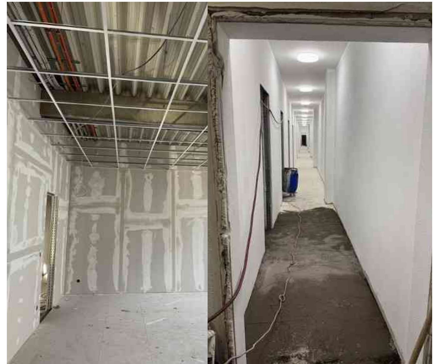
Wiederaufbau: neue Wände, neuer Boden
